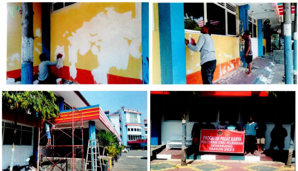
Gambar 2. 12 Padat Karya Pengecatan Gedung kelas
